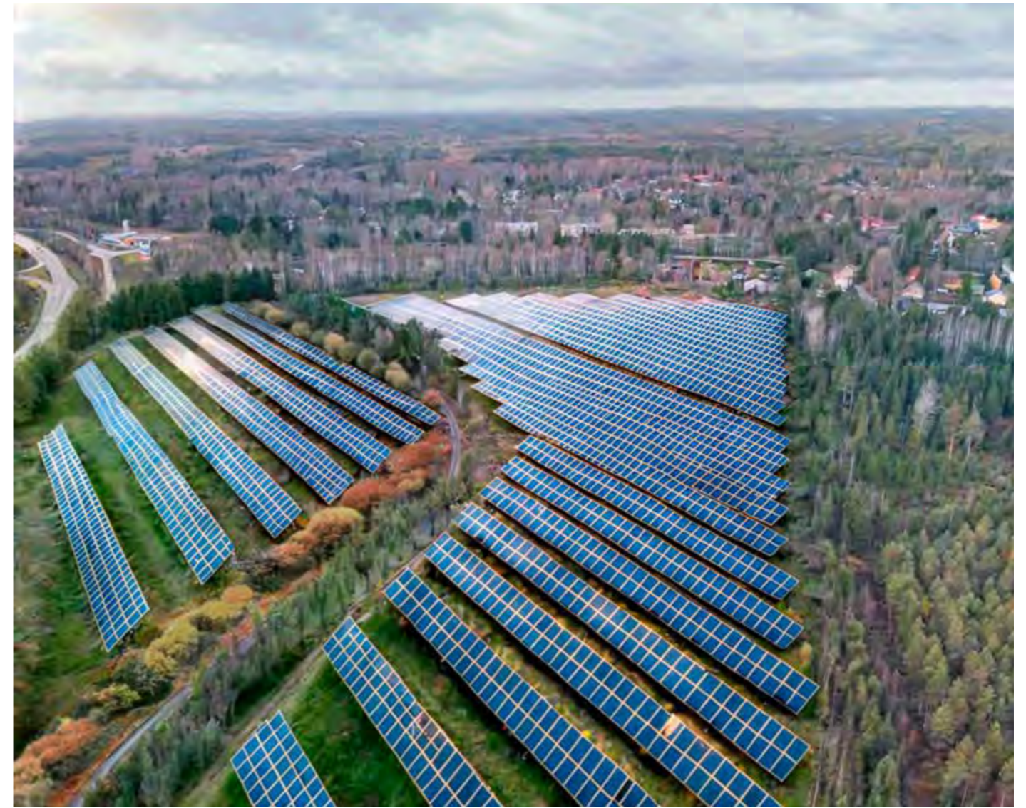
Kuva 31. Havainnollistava kuva kasvillisuudesta. Aurinkovoimalan alueen reunoille esimerkiksi sisäisten teiden yhteydessä voidaan istuttaa monikerroksellista ja -lajista kasvillisuutta, joka lisää alueen luonnon monimuotoisuutta ja visuaalista arvoa. Aurinkopaneelit eivät perustu suunnitelmaan, vaan ovat mukana havainnollistamassa kuvaa (mm. niiden suuntaus ei ole totuudenmukainen). (Kuva: Drooni-kuva Sitema Oy, reunakasvillisuus ja paneelit on lisätty Regraft -ohjelman avulla, 2024)
